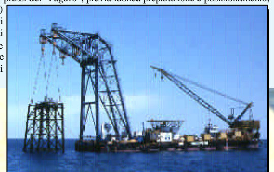
Fig. 4 - Affondamento di strutture derivanti dallo smantellamento di parti sommerse di vecchie piattaforme di produzione.
